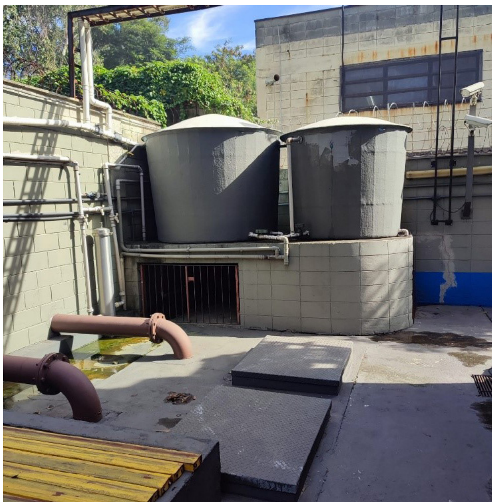
Sistema de reúso de água implantado no Parque Gráfico da FTD Educação. (Foto: Acervo FTD Educação)
